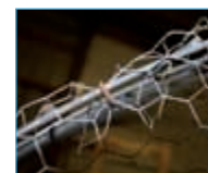
Costruzione gabbie Cage manufacture
